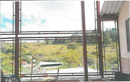
Foto 5: CERCO O MURO PERIMETRAL Sustitución malla de acero galvanizado en perímetro del establecimiento, con instalación fija y tensa, anclajes metalicos en intervalos regulares
