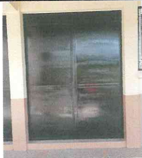
Foto 6: PUERTAS Mantenimiento a puerta metálica existente retiro de óxido, suciedad y pintura deteriorada; incluye cepillado, lijado y aplicación de pintura. Aula 1,2,3
