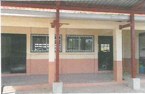
Foto 2: PINTURA EN MUROS INTERIOR Y EXTERIOR Preparación de la superficie y aplicación de pintura a dos manos, en paredes interiores y exteriores del establecimiento.
