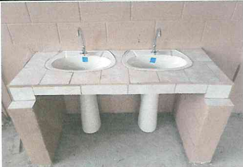
Foto 3:SERVICIOS SANITARIOS Y SUS ACCESORIOS Sustitución de lavamanos, accesorios y conexiones.
